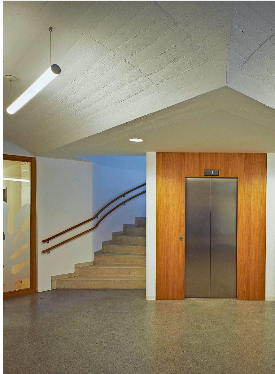
Früher lag die Klausur des Ordens beim Eingang. Deshalb findet sich hier ein Kreuzgewölbe aus Stahlbeton, das von alten Kirchen inspiriert sein dürfte.
